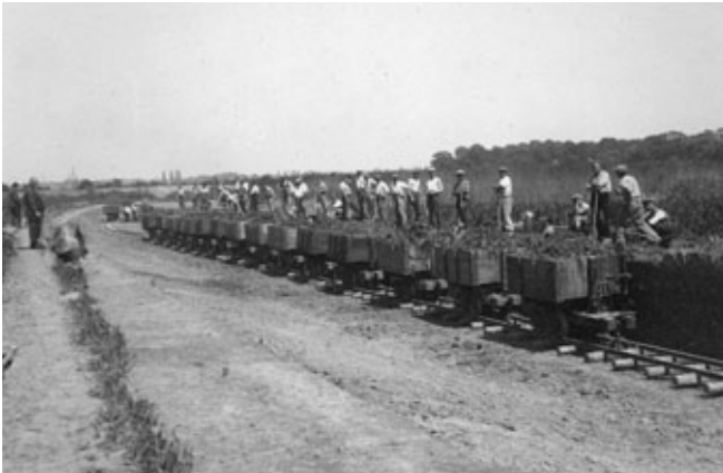
Bild 1: Regulierungsarbeiten an der Nidda 1930. Mit Lorenzjügen wurde das Erdreich abtransportiert. Einige der Schienen fanden wir noch bei den Umbauarbeiten 2012 im Fluss vor, sie waren wohl damals „vergessen“ worden.
