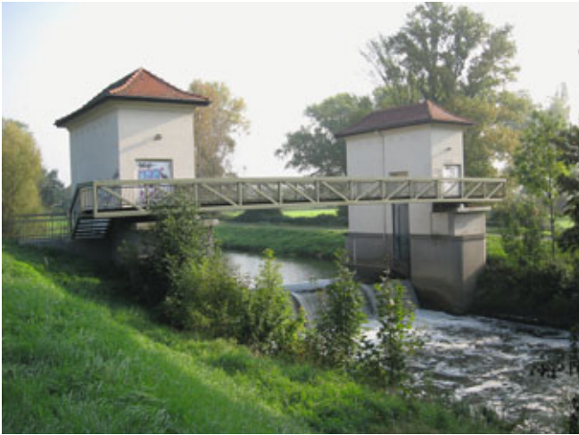
Bild 3: Das Höchster Wehr vor dem Umbau. Es hatte nur ein Schütz, das im Hochwasserfall gezogen wurde.
