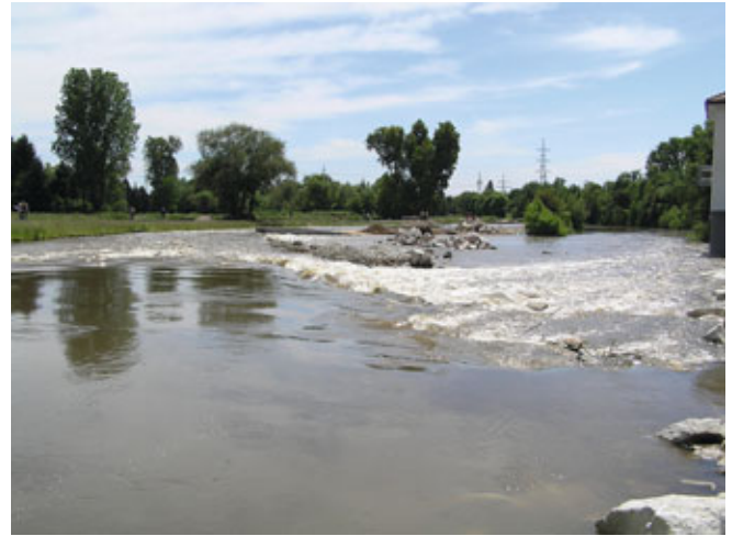
Bild 4: Das fertiggestellte Streichwehr bei mittlerem Abfluss der Nidda
