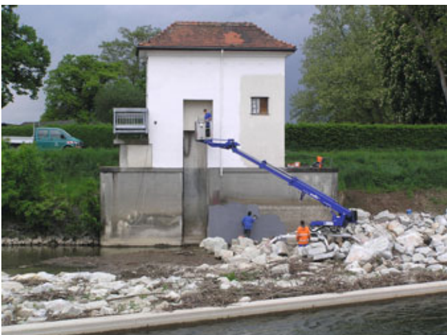
Bild 5: Das verbliebene Wehrhäuschen wird getüncht, links die neue Aussichtsplattform.
