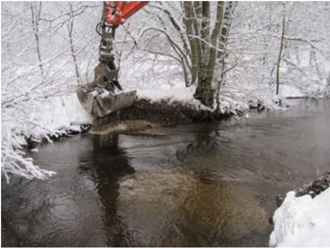
Bild 13: Einbau von Kies am Ufer gegenüber der Lenkbuhne (Foto: L. Tent)
