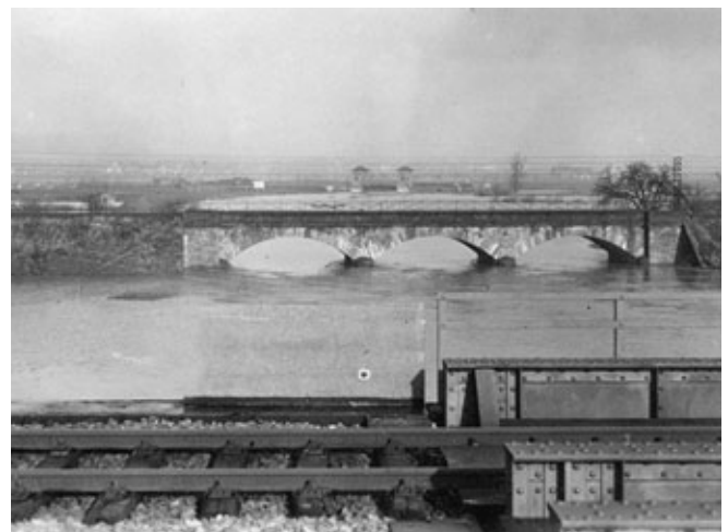
Bild 6: Bei Hochwasser des Mains drückt das Mainwasser in die Nidda und verursacht Überschwemmungen. Aufnahme von 1930, zuletzt sah es am Unterlauf der Nidda im Januar 2011 so aus.
